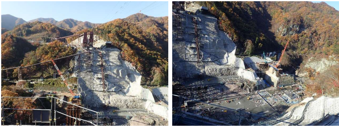
( 左写真：ダム本体建設現場 右写真：ダムサイト右岸天端から見た現場状況 )
